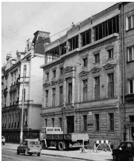
^ Fasada Domu Edyty Stein w trakcie remontu
