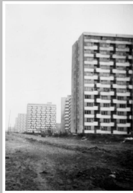
Budowa Alej Jerozolimskich w pobliżu Spiskiej
