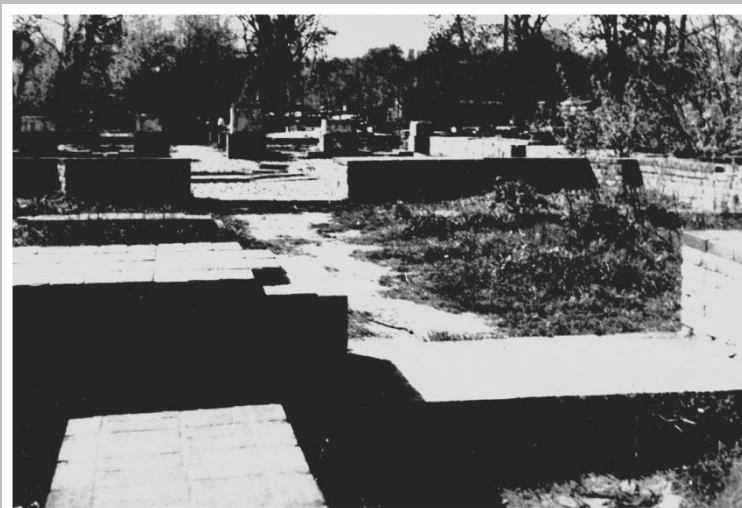
Fundamenty Zamku Ujazdowskiego
