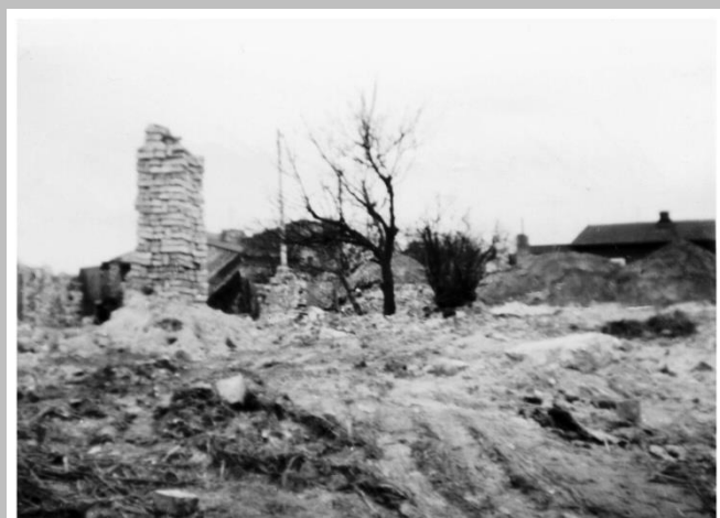
Wyburzane domy przy ul. Bema w pobliżu skrzyżo- wania ul. Wery Kostrzewy (ob. Bitwy Warsza- wskiej) z Alejami Jerozolimskimi (w budowie)
