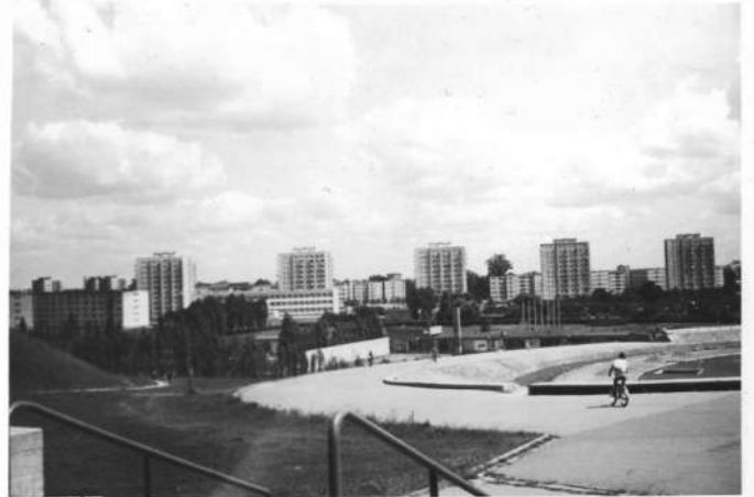
Północna część trybun i korony stadionu z widokiem na Dolny Mokotów.
