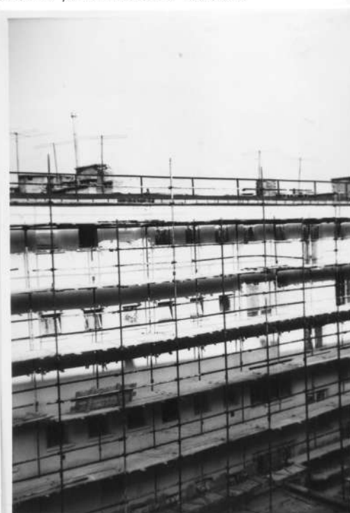
Widok domu przy Okolskiej 1/3 w czasie remontu, 12 lipca 1970 r.
