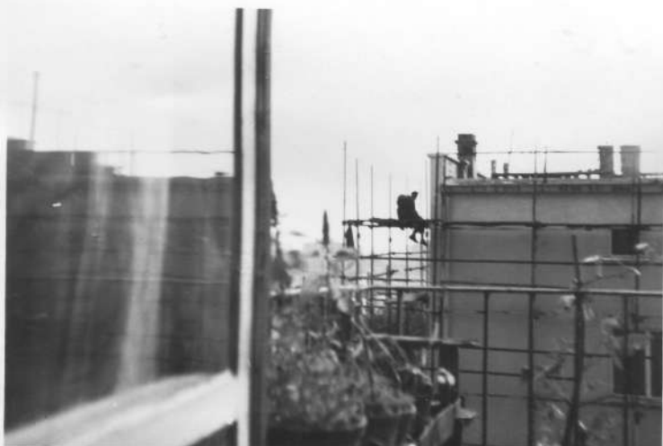
Widok domu przy Okolskiej 3 - zdejmowanie rusztowań po remoncie, 17 sierpnia 1970 r.
