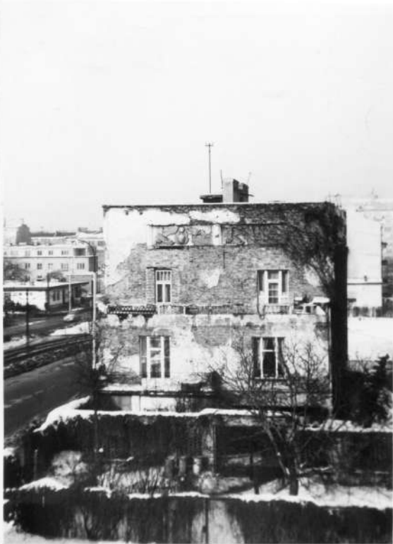
Na bocznej ścianie domu "Pod Skarabeuszami" widoczne są częściowo zniszczone płaskorzeźby, b. d.
