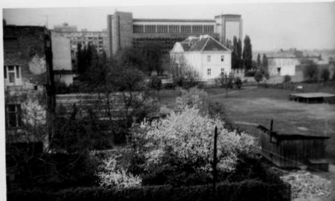
Widok z okna domu Puławska 101a na ogród domu "Pod Skarabeuszani" (Puławska 101). Widoczny kościół częściowo w rusztowaniach, 11 maja 1969 r.
