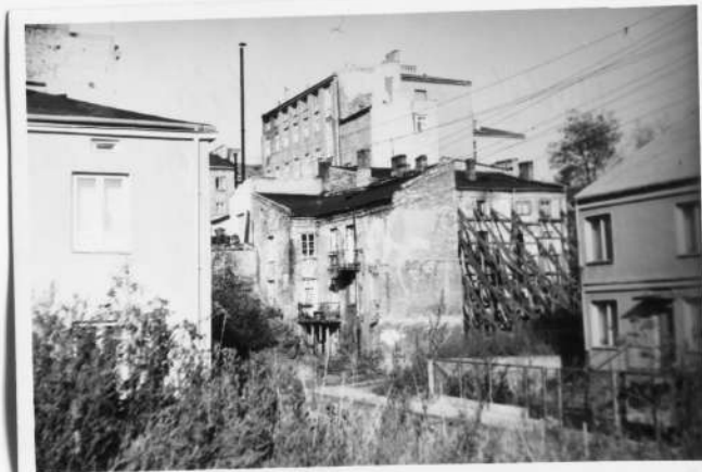
Widok ze schodów ul. Boryszewskiej, 1 listopada 1968 r.
