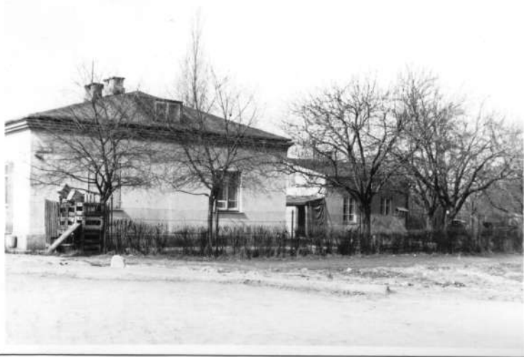
U wylotu ul. Lubaszki do Al. Wilanowskiej, 25 marca 1973 r.
