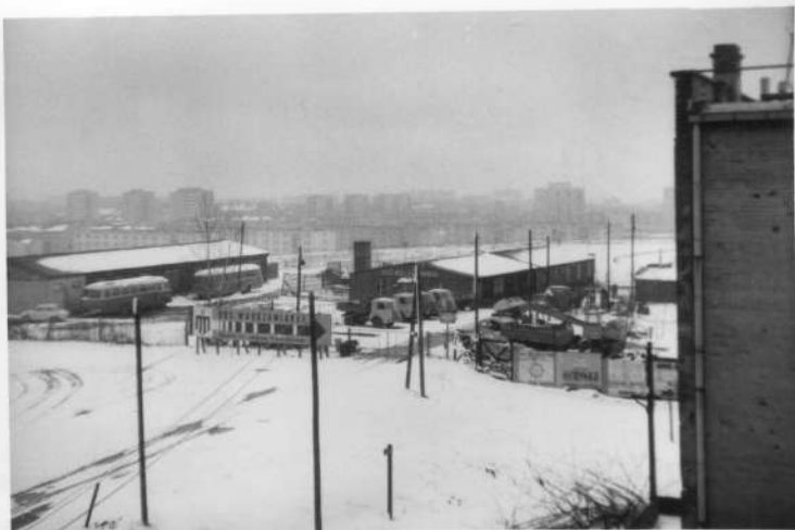
Widok w stronę skarpy. Barak po lewej stronie to sala szermierki SKS "Warszawianka", a po prawej to "Hydrobudowa-6", 20 kwietnia 1969 r.
