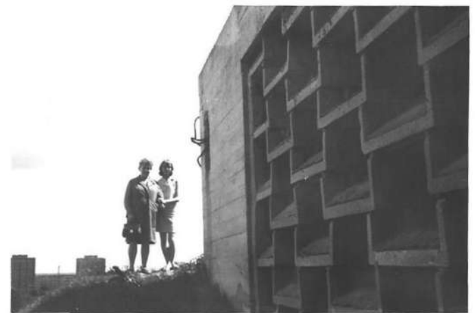
Ściana oporowa ponad koroną stadionu.
