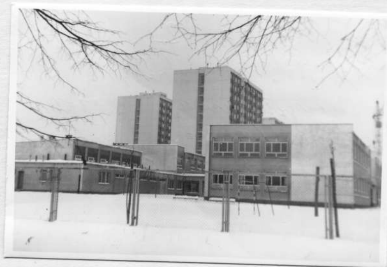
Widok na Technikum Energetyczne przy ul. Żywnego 14 stycznia 1968(?) r.
