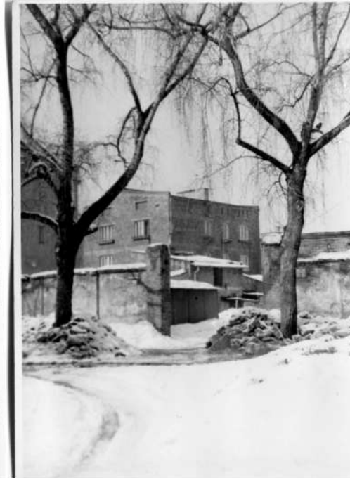
Wjazd do fabryczki przy ul. Racławickiej
