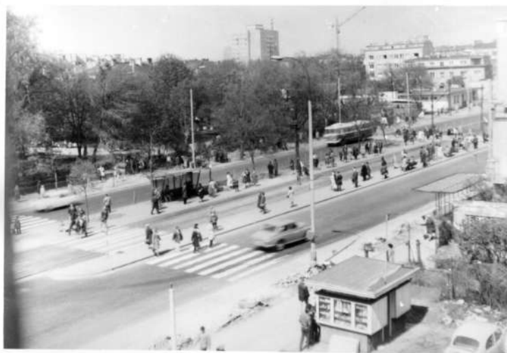
Widok na przystanki tramwajowe przy Odyńca, przesunięte bardziej na północ na pocz. lat 70., w celu umożliwienia wyjazdu z ul. Odyńca w kierunku centrum, 30 kwietnia 1972 r.
