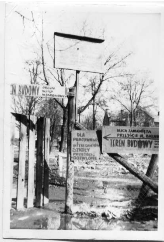
Wejście na plac budowy osiedla "Na Skarpie". Ul. Żywnego 30 marca 1969 r.
