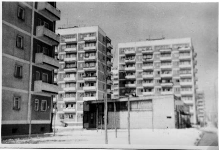
Ul. Modzelewskiego. Widoczny pawilon obecnie (2026) nie istnieje, 5 kwietnia 1970 r.
