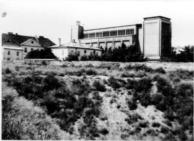
Widok kościoła z krawędzi skarpy, ok. 1964 r.
