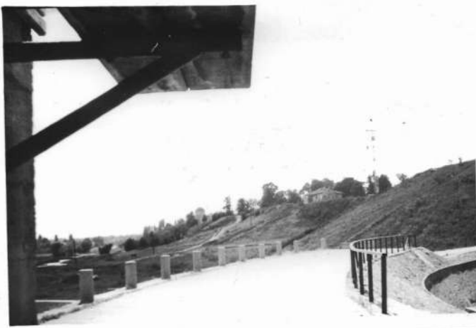
Widok spod pylonu stadionowego zegara na Królikarnię i d. Gimnazjum Giżyckiego.
