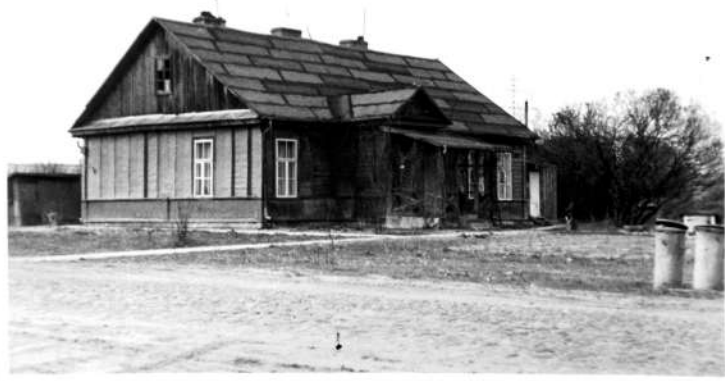
Stary dom drewniany przy ulicy, naprzeciwko fortu, 14 kwietnia 1968 r.
