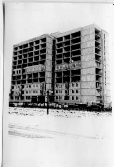
Budowa domu przy Bukowińskiej, 19 stycznia 1969 r.
