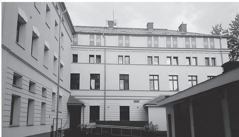
Fot. 3. Dom Generalny. Po lewej stronie ściana z oknami Biblioteki Zgromadzenia Sióstr Loretanek – widok z wnętrza dziedzińca
