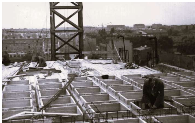
Budowa nowego kościoła. (z archiwum parafii)
