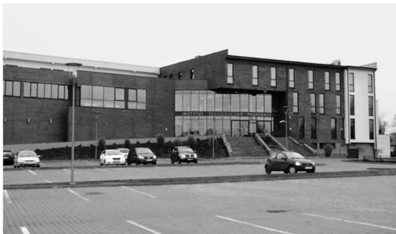
Fot.1. Budynek Instytutu Teologiczno-Pastoralnego (fot. B. Dec)
