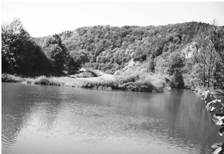
Fot. 1. Spiętrzenie Dunaju przed elektrownią wodną, nieopodal klasztoru w Beuron [fot. autor]
