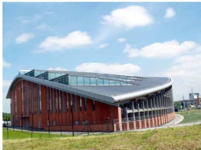
Widok budynku od strony południowo-zachodniej
