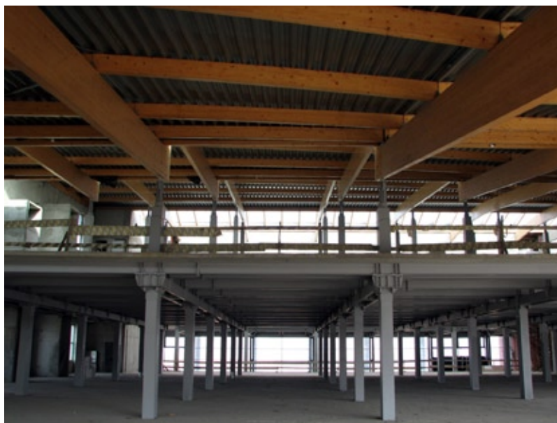
Konstrukcja stalowa budynku – stan surowy*
