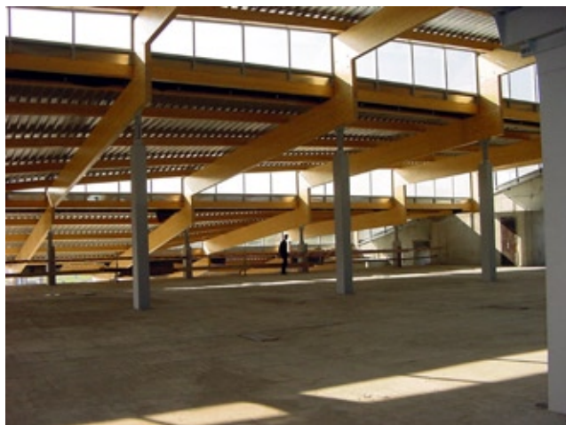
Konstrukcja dachu budynku
