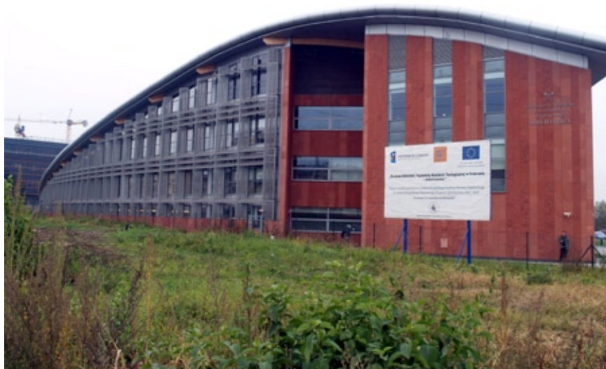
Widok budynku od strony południowo-wschodniej
