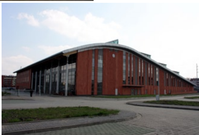
Widok budynku od strony pół- nocno-zachodniej
