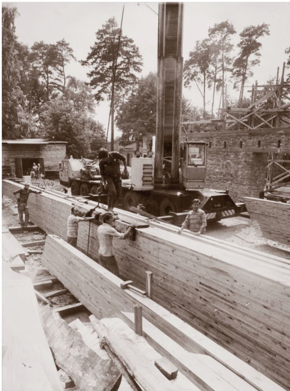
Przygotowanie elementów konstrukcji dachu świątyni.
