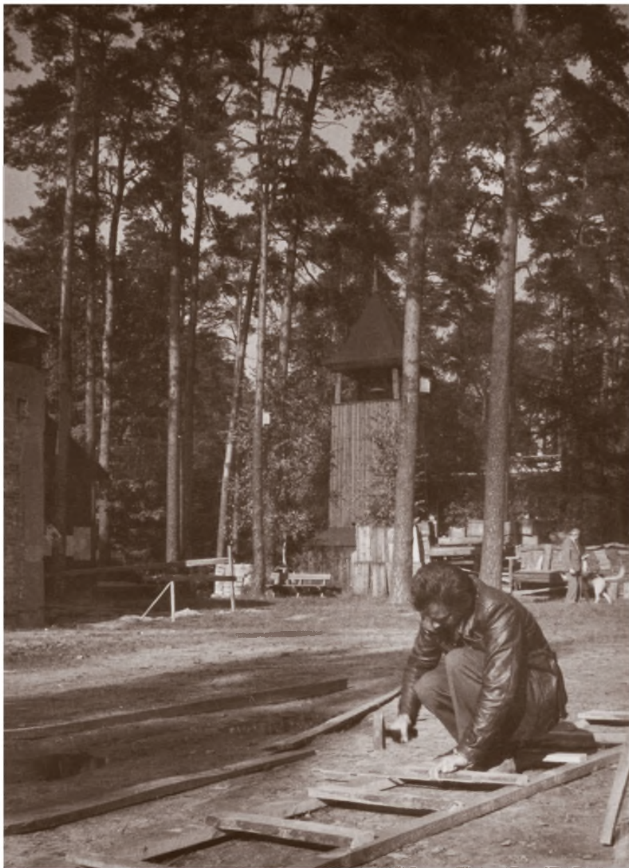
Praca przy budowie. W tle, pośród sosen widoczna drewniana dzwonnica.
