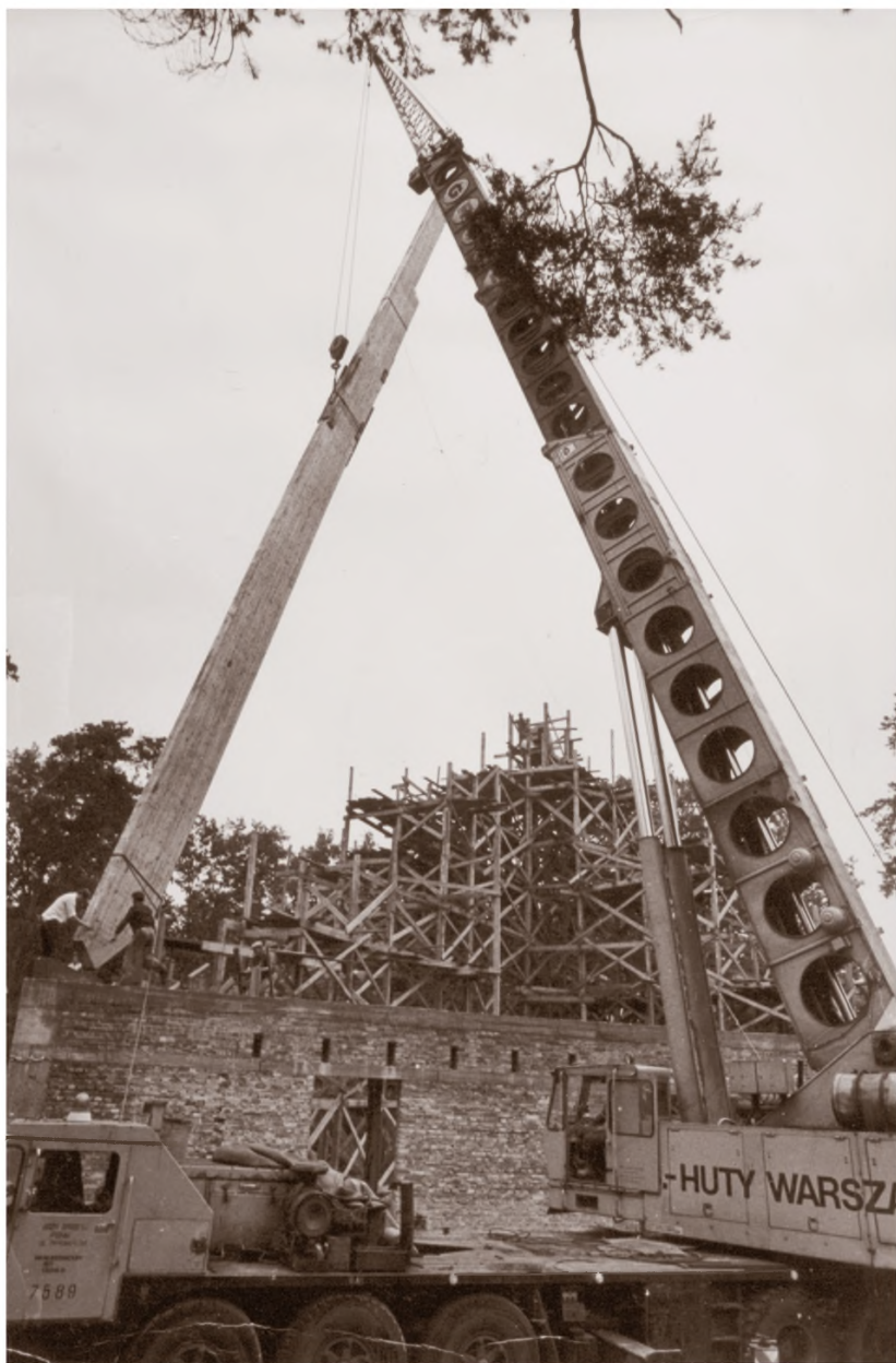
Wielki dźwig precyzyjnie ustawia ogromne krokwie dachu świątyni.
