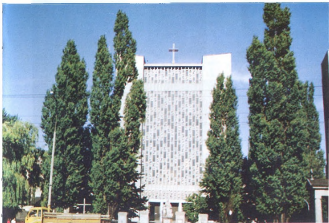
Kościół Św. Michała w Warszawie, budowany w latach 1958-1966, staraniem ks. proboszcza Stefana Piotrowskiego.
