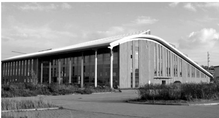
Fot. 6 Budynek od strony wejścia głównego do biblioteki
