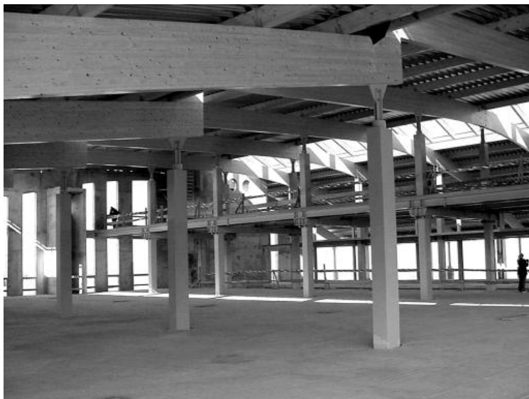
Fot. 7 Konstrukcja budynku, czytelnia na 2 piętrze
