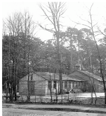
Drewniana kaplica w Zalesiu Dolnym w 1967 r.
